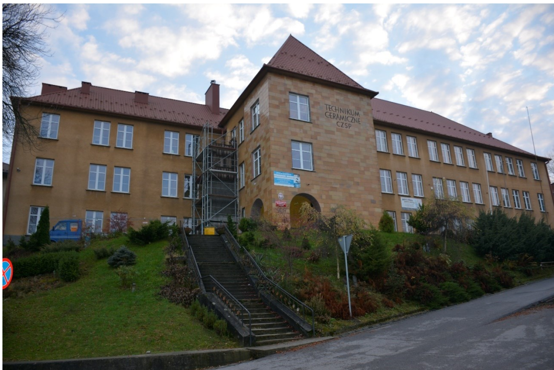
Fotografia 6 Budynek nieczynnego Technikum Ceramicznego w Łysej Górze
