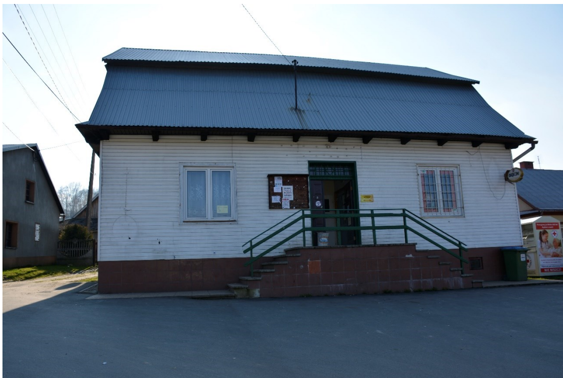
Fotografia 2 Budynek komunalny w Dolach
